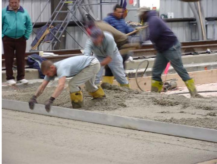
FIGURE 34. STRAIGHTEDGE STRIKE-OFF OF CONCRETE IN TEST STRIPS AT THE NAPTF
