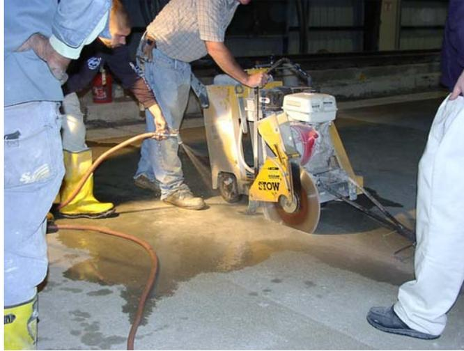
FIGURE 37. WET SAW CUTTING JOINTS IN CONCRETE TEST STRIPS AT THE NAPTF
